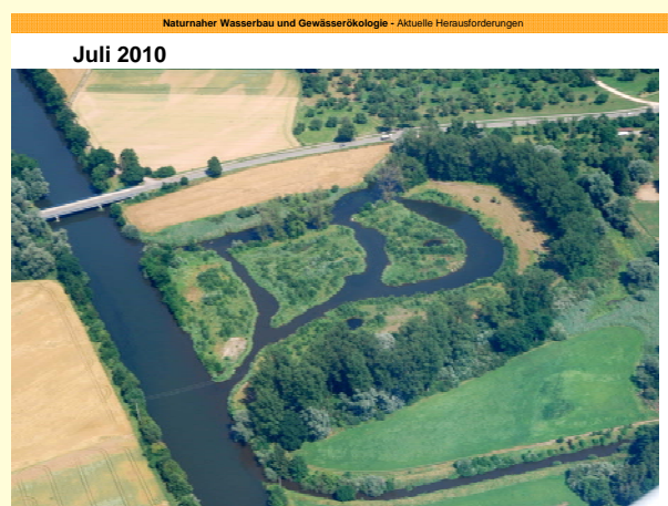
Zustand nach der Sanierung
